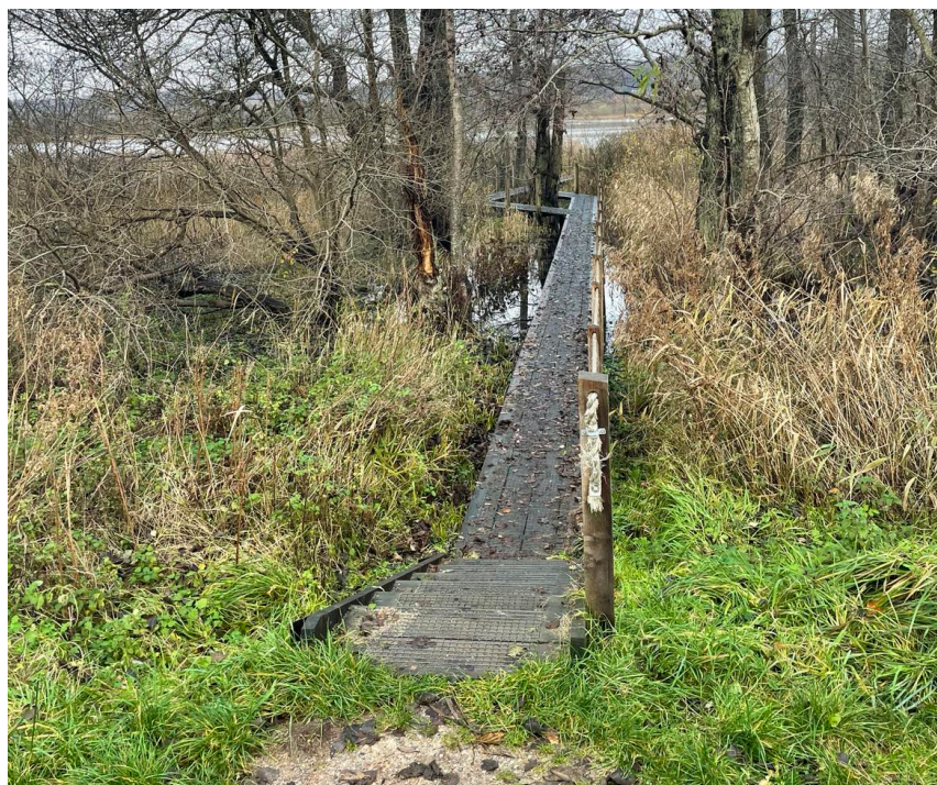
Billede 1: Gangbro uden sikkerhedskanter
